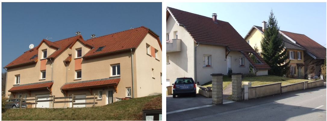
Réalisations récentes disséminées dans le noyau bâti traditionnel du village
