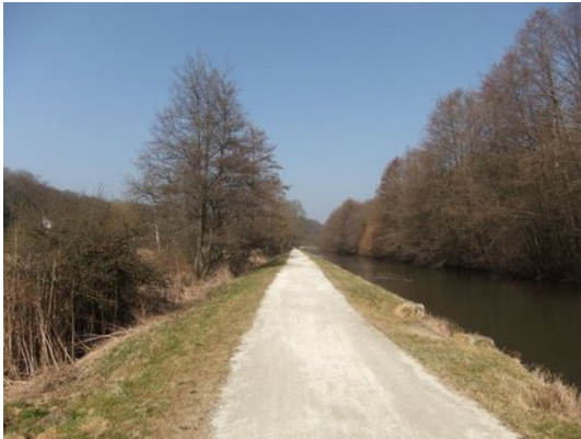
Le tracé Nord du Canal de Montbéliard à la Haute Saône le long de l'A36
