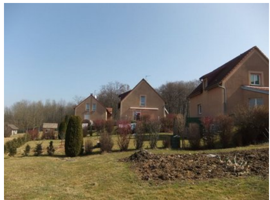
Ensemble de constructions neuves de la rue de la Bouloye
